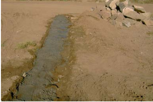
شكل (38) تعبئة الفراغات بين الأحجار
