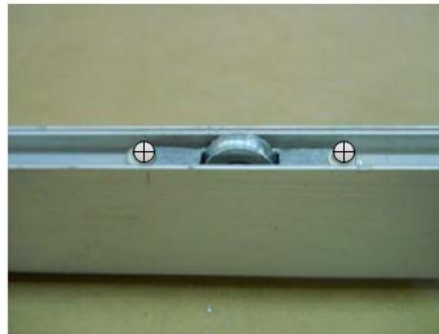
شكل رقم ٧١: عملية تركيب العجلات
